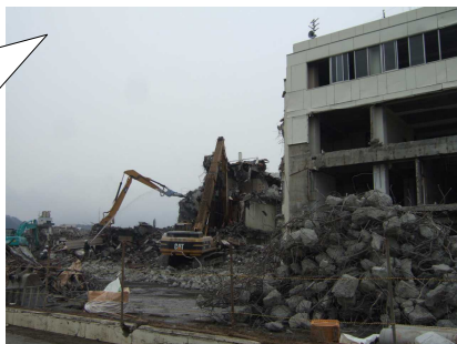
旧陸前高田市役所庁舎 H25.2.14 撮影
