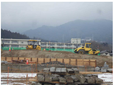
災害公営住宅予定地の盛土の様子 (陸前高田市出身 Iさん)
