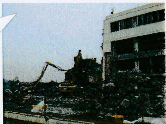
旧陸前高田市役所庁舎 H25.2.14 撮影
